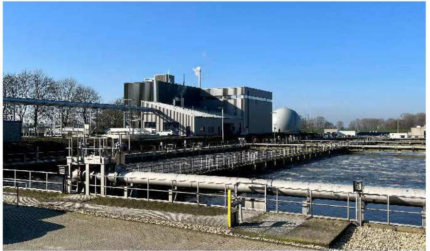
Die Pyreg-Klärschlamm-Anlage PX0750, die im März 2023 als Teil einer neuen Thermokompaktanlage im Klärwerk Kleve-Salmroth in Betrieb genommen wurde. Bei einem Input von stündlich bis zu 300 kg Klärschlamm werden in der Anlage bis zu 100 kg Karbonisat generiert – bei einer zusätzlichen Wärmeleistung von etwa 250 kW th . Foto: Pyreg
